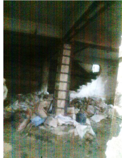
الشكل (37) تدعيم الأعمدة في أحد أقبية المباني
